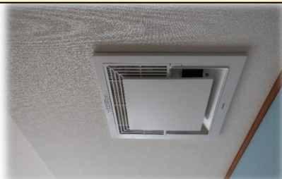
天井に設置した換気装置
